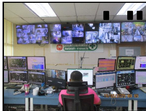
ภาพที่ 2.2 ภาพกล้องวงจรปิดเพื่อสังเกตปลายปล่องหม้อเผาและระบบคอมพิวเตอร์ควบคุมภายในห้องควบคุมการผลิต (CCR)
