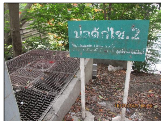
ภาพที่ 2.16 ระบบบำบัดน้ำเสียแบบบ่อกรอง-บ่อซึม สำหรับบำบัดน้ำเสียที่มาจากห้องส้วม
